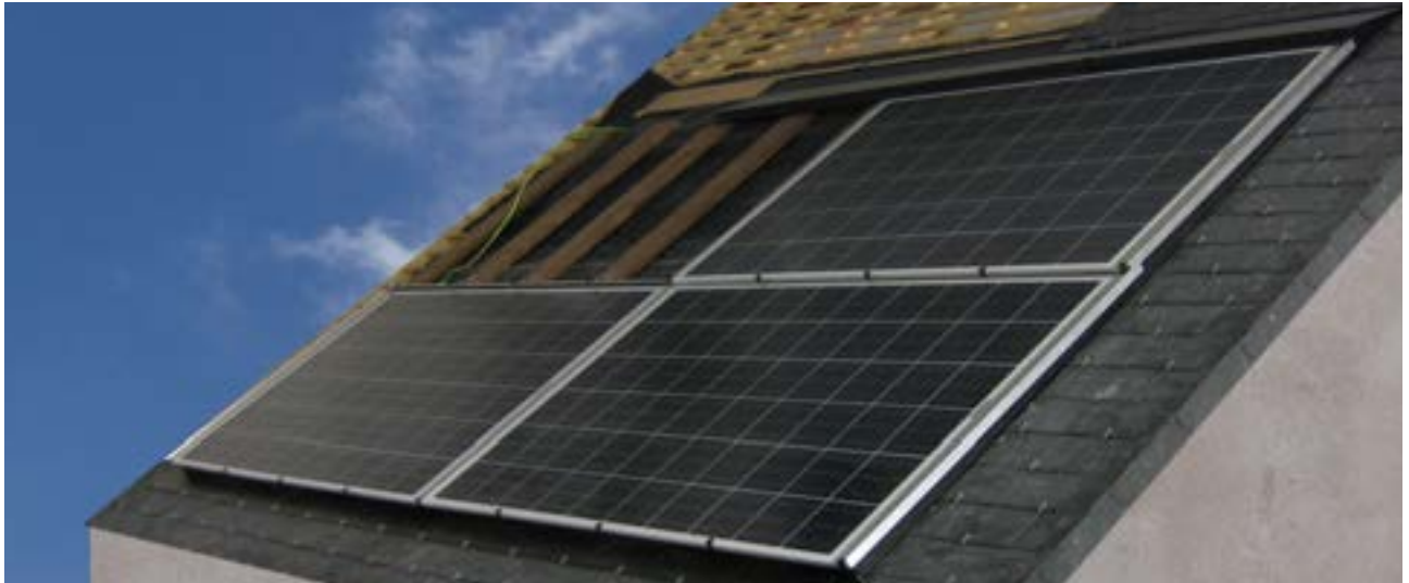
Esemio di posa orizzontale dei moduli a totale integrazione Solterra TI
